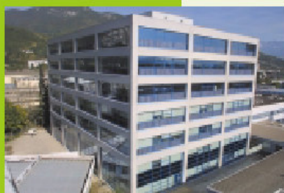
Façade photovoltaïque sur le bâtiment de ST Microelectronics (source : ST Microelectronics).
