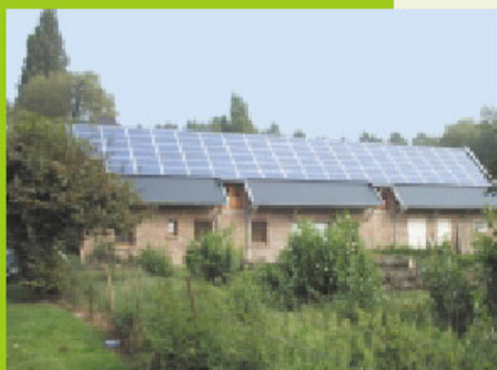
Bâtiment d'ERM Electronique (source : SUNWATT).
