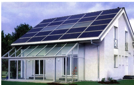
Toiture modules photovoltaïques
